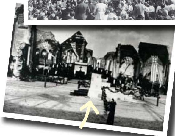
Bilder von oben linke Seite 1. NSDAP Kundgebung auf der ehemaligen Adolf-Hitler-Straße (heute Schuppenstr. Letter Str., Dülmener Str.) - | 2. Zerstörte St. Jakobi Kirche- 3 und 4 General Montgomery bei Befreiung Coesfelds März 1945 - | 5 zerstörte St. Jakobi Kirche Ansicht Ritterstr | rechte Seite: 6 Ruinen am Jakobiring - 7. Apsis der zerstörten St. Jakobi Kirche vom heutigen Krankenhaus aus gesehen. | 8. Gottesdienst in der Kirchenruine - | 9. Grundstein der heutigen Kirche (Pfeil im Vordergrund) | Hintergrundbild unten: Bruchsteine des zerstörten Portals der St. Jakobi Kirche (wiederhergestellt)
